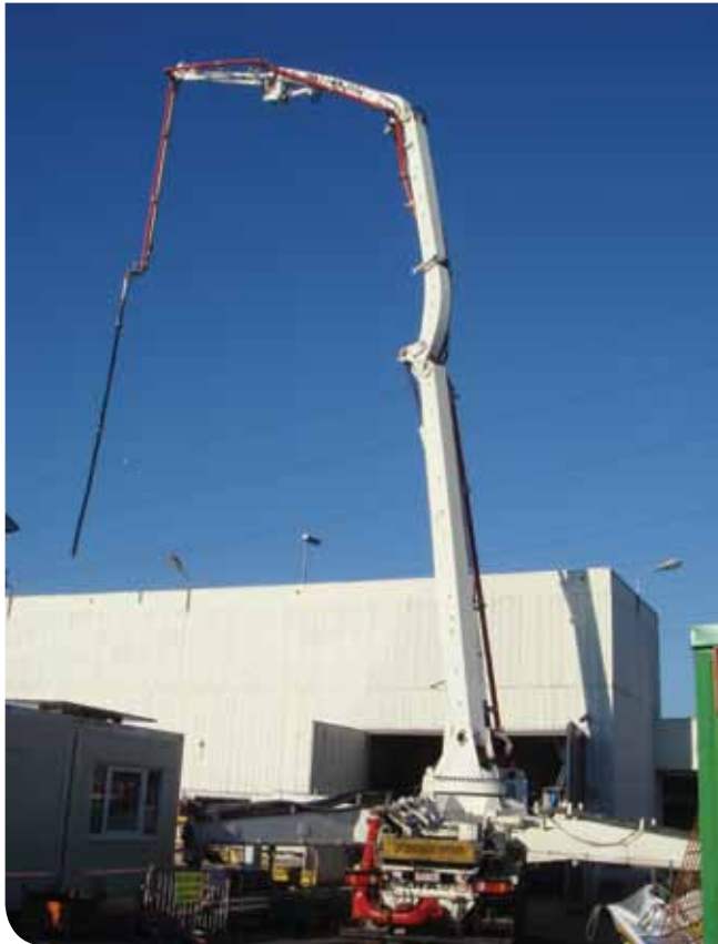
Renovatie van de waterkrachtcentrale van Lixhe, december 2013: betonmachine om het stroomafwaarts gedeelte op te bouwen. De renovatie van deze centrale heeft 4 miljoen euro gekost in 2013, op een totaal van 12 miljoen euro verspreid over twee jaar.
