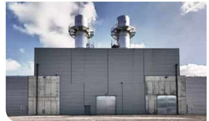
De vierde eenheid op de site van Angleur werd gebouwd in 2010. Het zijn twee gasturbines met open cyclus van elk 63 MW die in minder dan tien minuten op volle kracht kunnen draaien, dankzij een lage thermische inertie. Deze 'piek'centrale kan de verbruikspieken van 70 000 gezinnen opvangen.
