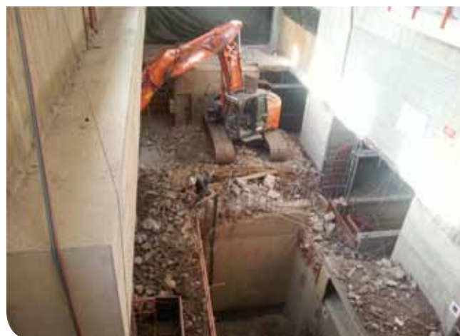
De afbraak van een gedeelte van de waterkrachtcentrale van Lixhe (hier de kokers en het niveau 'machinekamer') zorgde voor een grote hoeveelheid bouwafval dat grotendeels verbrijzeld en gerecycleerd werd.
