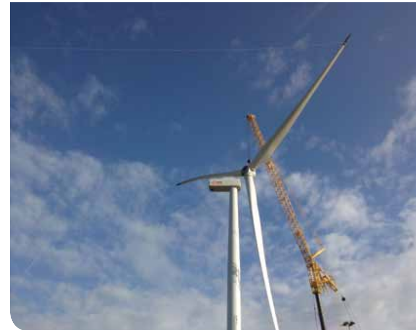
Bouw van de windmolen op de site van Marlux.
